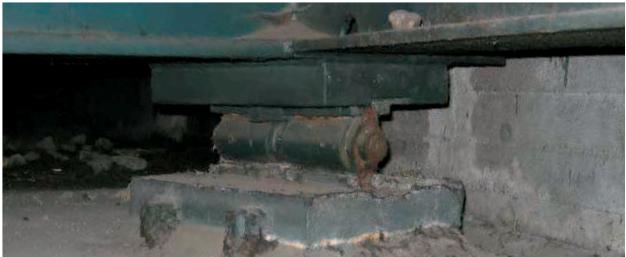
Vor der Sanierung - altes Rollenlager
