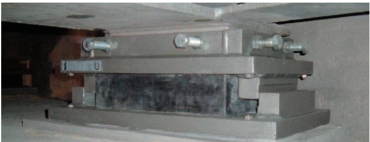
Nach der Sanierung -neues Verformungslager (V1)
